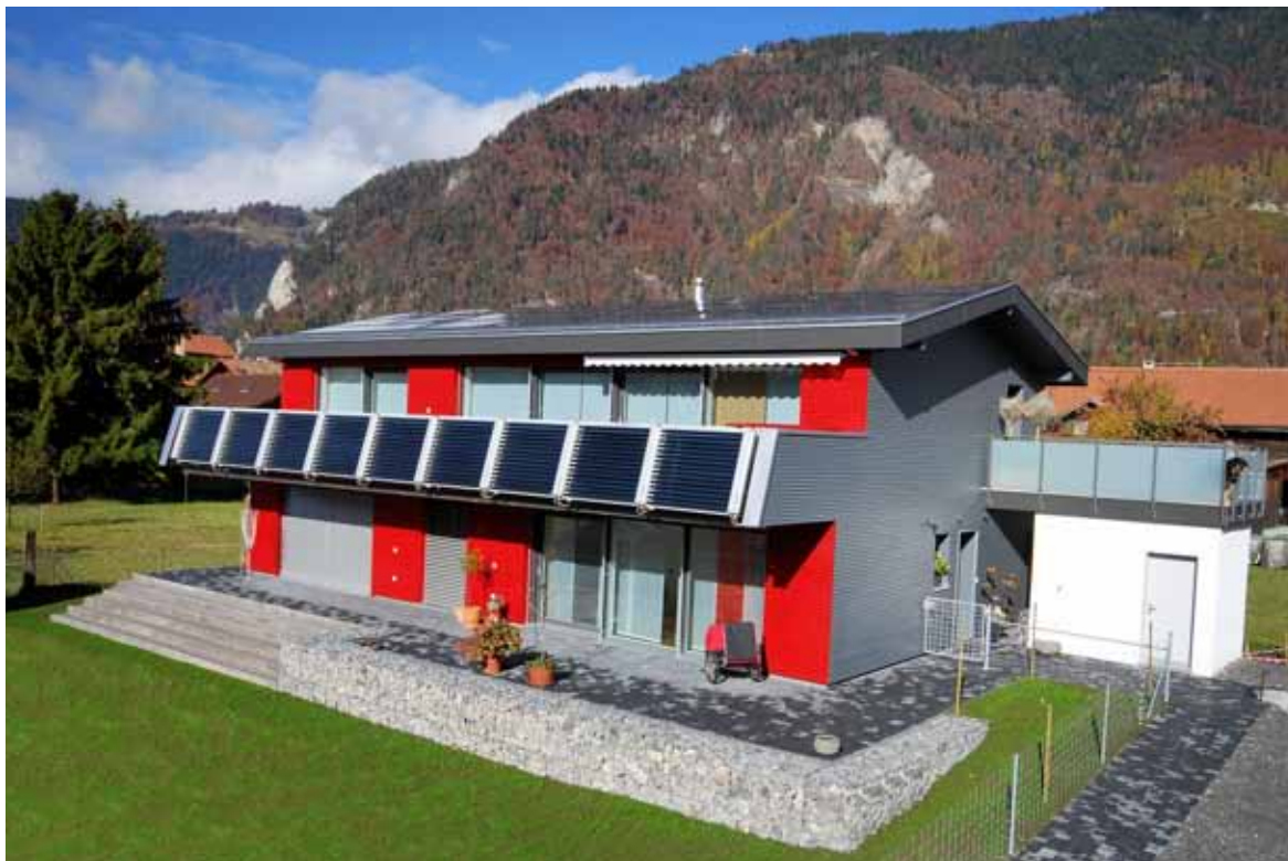
In Matten bei Interlaken wurde das zweite Minergie-A-Eco-Haus der Schweiz zertifiziert.
