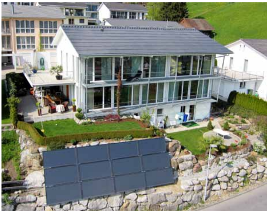
Das Haus in Mangelegg SZ hatte zu wenig Fläche, weshalb die thermische Anlage neben dem Haus platziert werden musste. Später wurde noch eine Photovoltaik-Anlage auf das Dach montiert.
